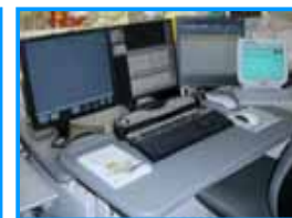
コントロール (操作卓)
