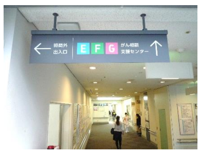
天吊り誘導サイン
